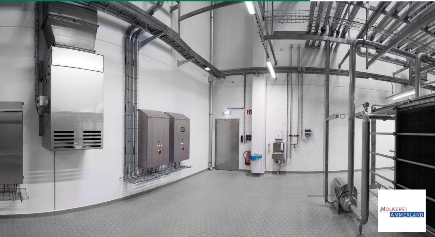
Klimaschrank zur Regelung der Zu-, Ab- und Frischluftmengen für mehrere Zonen über interne Steuerung
